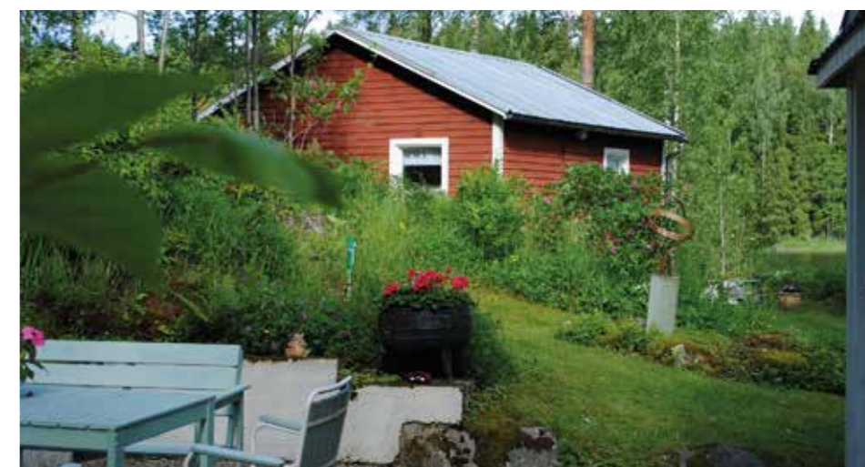
HUSBESIKTA. Det är klokt att besöka fritidshuset som är till salu. Fel som upptäcks efter köp och som ingår i köparens undersökningsplikt kan du aldrig i efterhand få ersättning för.
