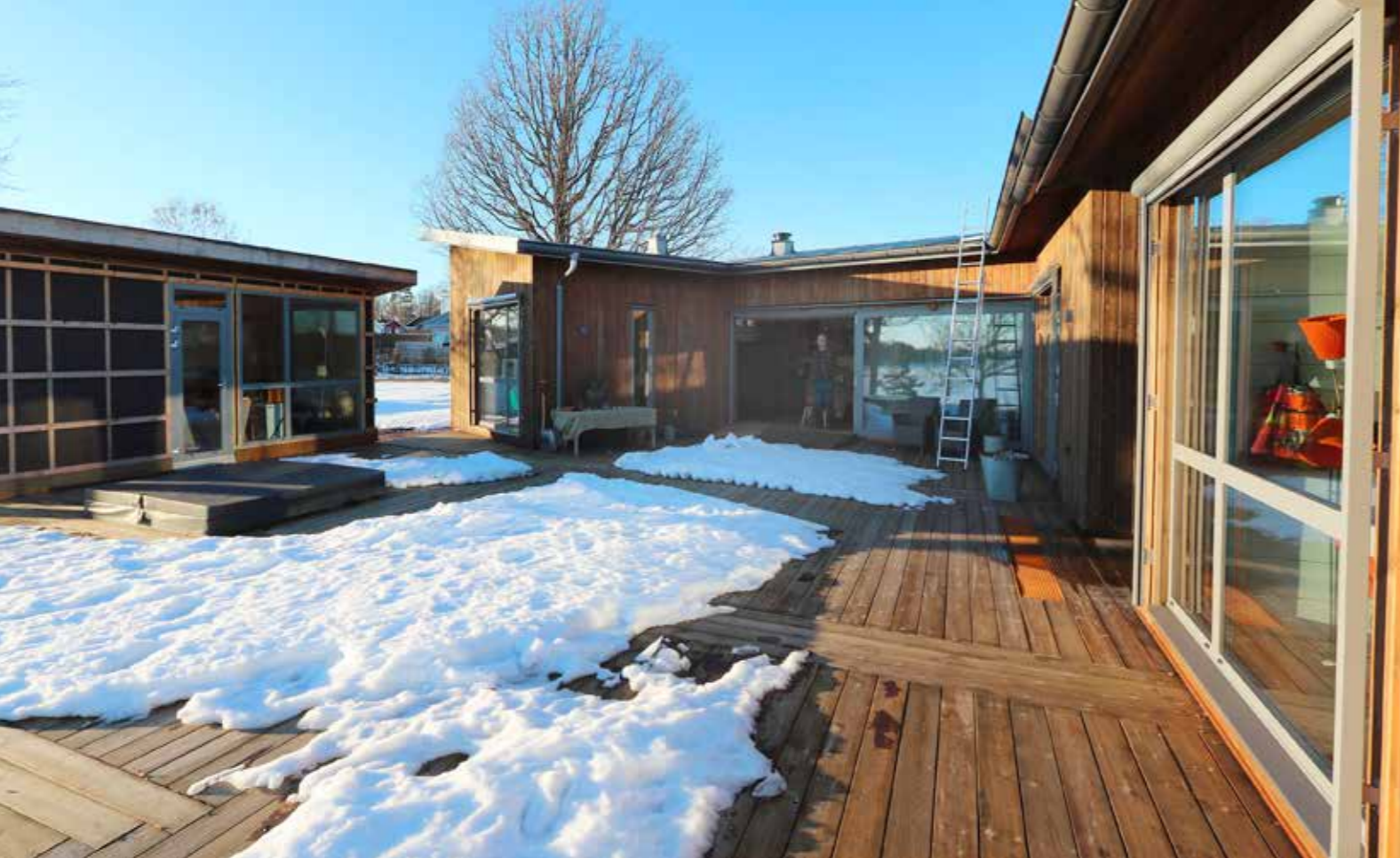
HÅLLBART. Sälja? Renovera? Riva och bygga nytt? Anders och Ingegerd valde det senare. – Vi valde miljöanpassat och närproducerat, plus att återanvända mycket av det gamla som redan fanns, berättar de.
