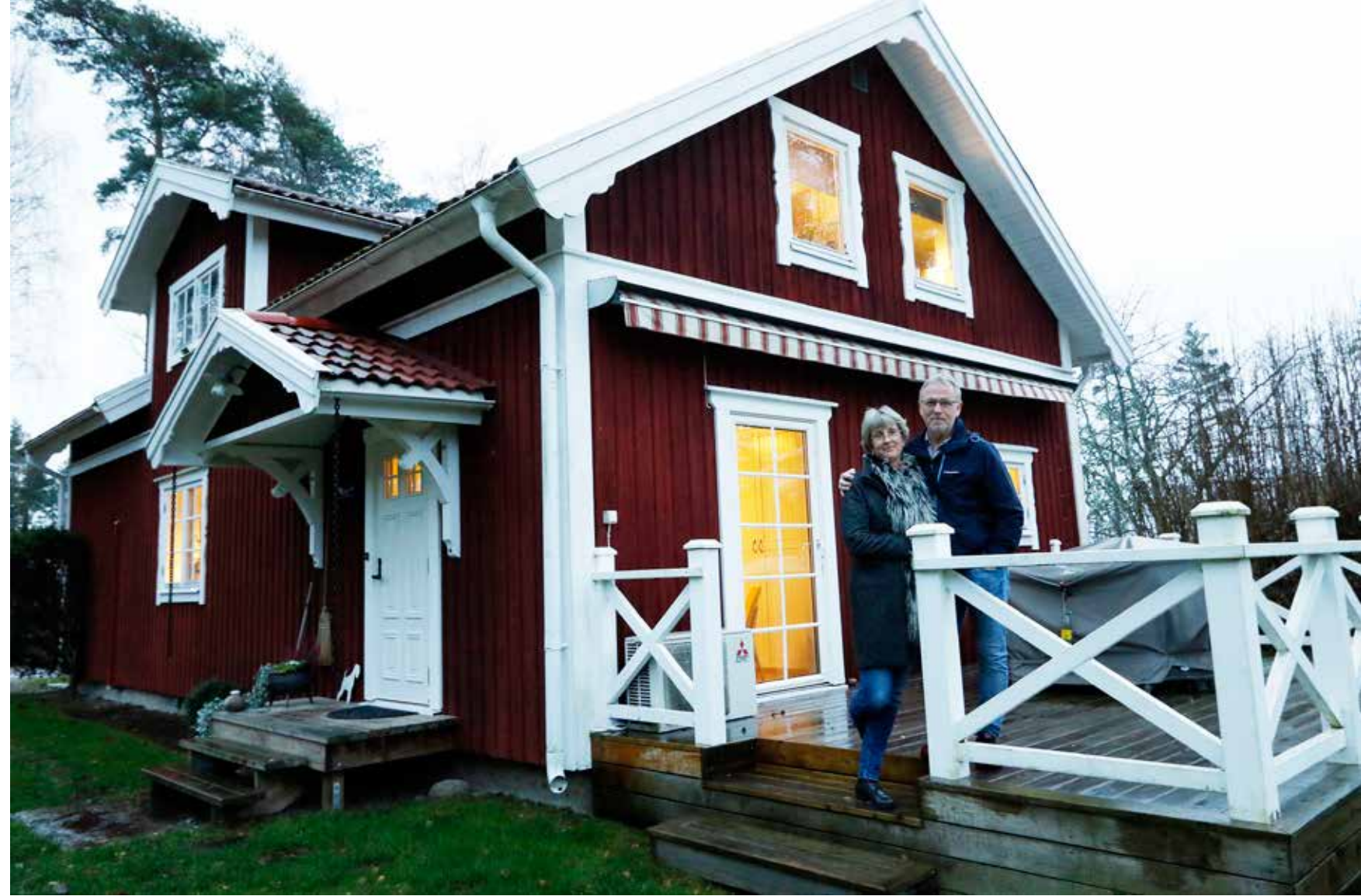
HELRENOVERAT. Åke och Pia kan nu pusta ut efter att ha förvandlat släktens sommarstuga till en genuin året-runt-bostad. Politikernas nu bortglömda modeord resiliens är verklighet här. Vatten finns i egna brunnen, jordkällare till maten och vedeldning för uppvärmning. Här kan de klara sig länge utan el.
